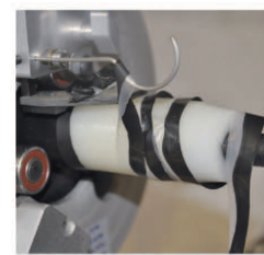
· 外半導體剝除 斜坡度同時完成
