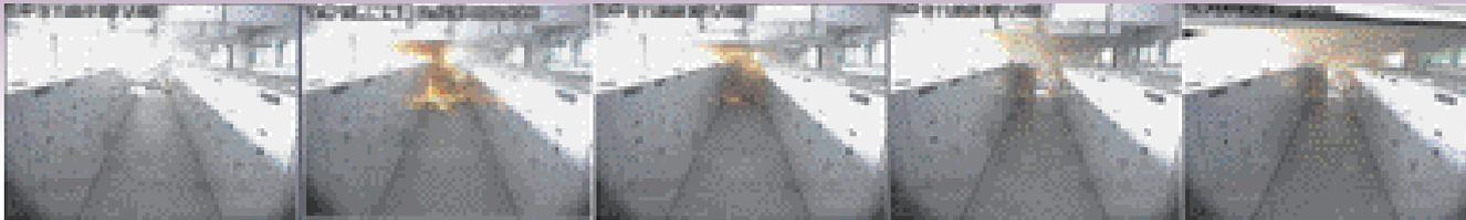
實況，被變電所影像監控系統的遠方同一攝影機自動記錄發生全部歷程的5個畫面。發生位置是在裝甲開關箱（MCSG）內的11kV匯流排比壓器，產生的電弧氣浪將原先上鎖的箱門爆開，且噴出比壓器等器材殘屑在地上，被爆開的箱門已有變形，可見電弧事故的威力，也顯現沒有抗電弧結構設計的開關箱即使是有「裝甲」密封的，也是存在著風險。所以這個案例直接證實了美國的一些作法是正確的且是必要的。
